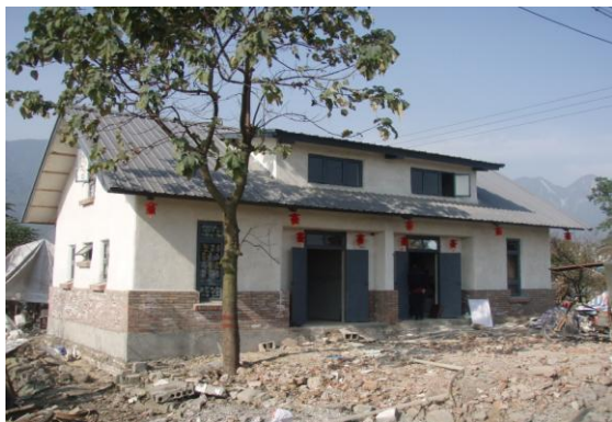
图5 建成的新龙村503示范房
