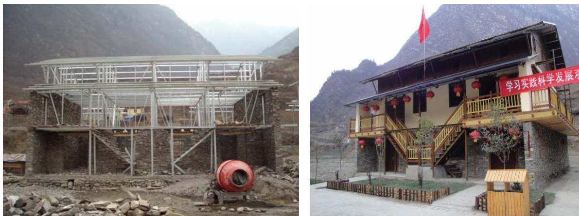
图1 杨柳村羌族建筑示范房建好前后对比
