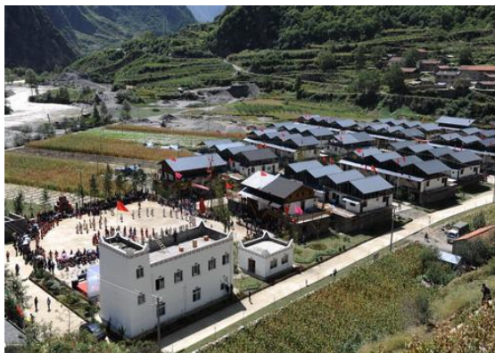
图6 实际建成后的杨柳村现状图 208
