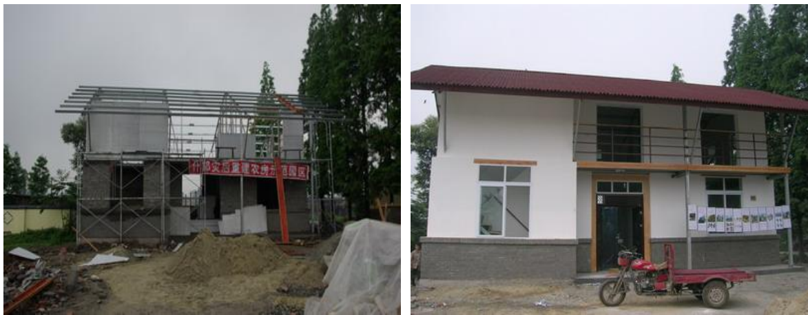
图3 银池村羌族建筑示范房建好前后对比
