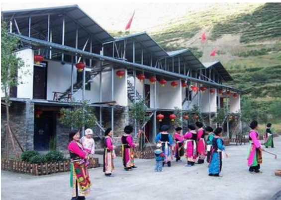
图3 完工后的一栋四联户轻钢永久性住房
